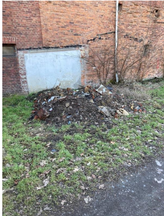
Bild 2: Schutthaufen rechts neben Container
