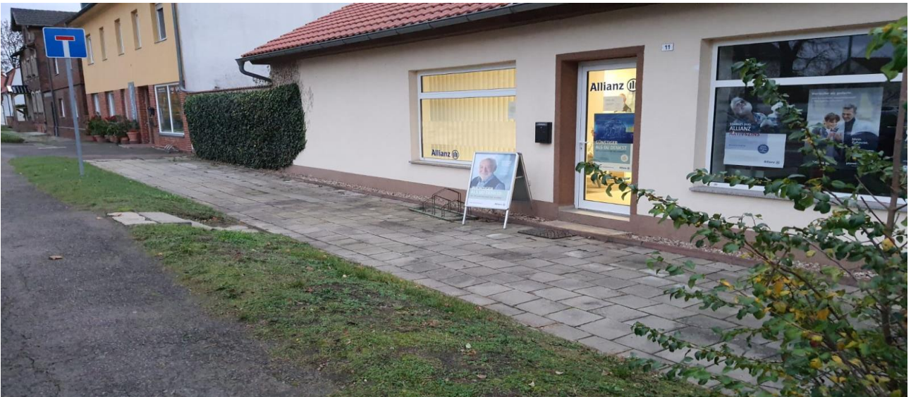
Bild 2 Gehweg mit Treppe vor Allianz Alte Wittenberger Straße
